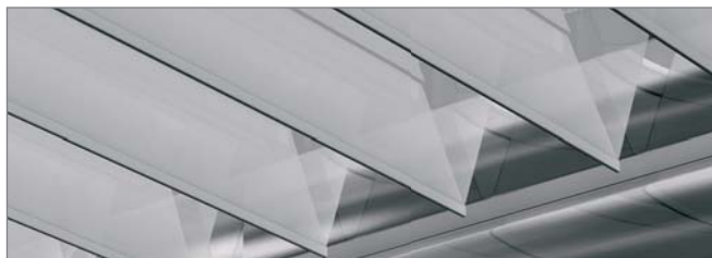
Cubierta del fuelle en tejido translúcido y de doble trama
